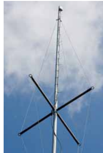
De zender is op 10 meter hoogte bij de huurstal geplaatst. Deze hoogte is nodig om geen last te hebben van obstakels tussen zender en ontvangers.
